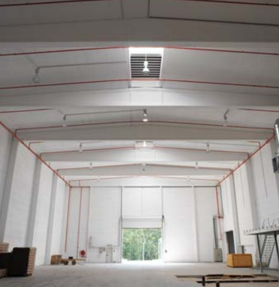
Entrepôt pour produits inflammables.
