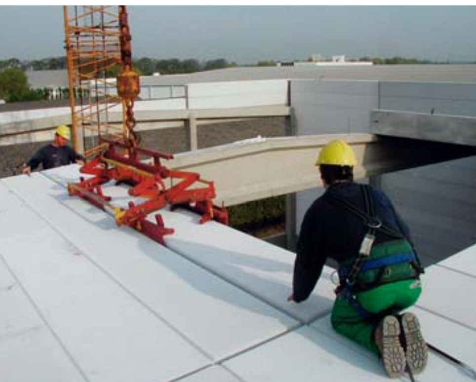
Les dalles de toiture Hebel permettent de protéger les bâtiments adjacents en cas d'incendie.
