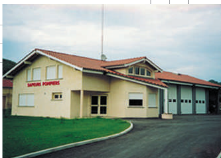
Caserne des Pompiers de Saint-Savin - 38
