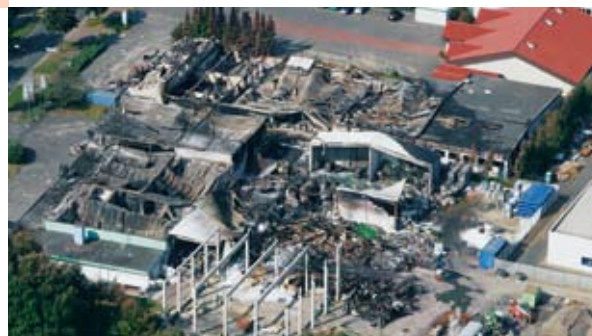
Un exemple impressionnant des propriétés du béton cellulaire est fourni par l'incendie qui s'est déclaré le 31 août 2005 dans une fabrique de peintures en Allemagne. Ici, une défaillance technique dans l'entrepôt de peintures, de vernis et de cuves de produits chimiques a déclenché un incendie qui s'est propagé non seulement aux halls de production de l'usine de peintures, mais également au hall de production d'une entreprise textile adjacente. Les opérations d'extinction ont été retardées par l'explosion de plusieurs cuves de produits chimiques et ont également été fortement gênées par les projections de matériaux et le développement de fumée. Le résultat : l'entrepôt a été intégralement détruit et le hall de production de l'usine de peintures a été presque complètement détruit. Seul le magasin de produits dangereux et les murs du bâtiment administratif ont été épargnés. Tous deux étaient construits en béton cellulaire.
