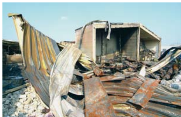
Image typique : Après un violent incendie, un hall en béton cellulaire se dresse pratiquement indemne au milieu des décombres. Le reste de l'usine a été complètement détruit par les flammes.
