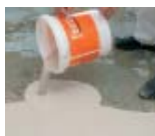
Epandre l'enduit de ragréage et laisser la masse se répartir
