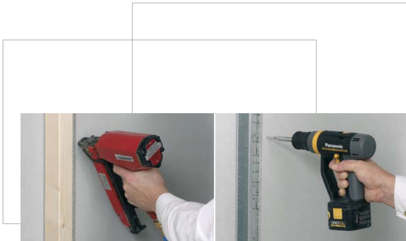
Agrafer ou visser sur l'ossature
