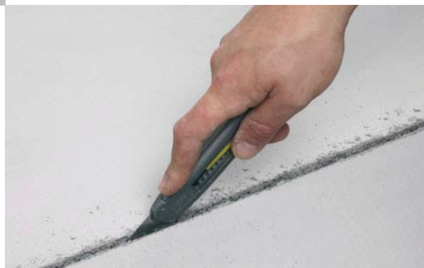
... rompre la plaque sur une arête
