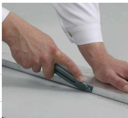
Entailler la plaque avec un cutter ...
