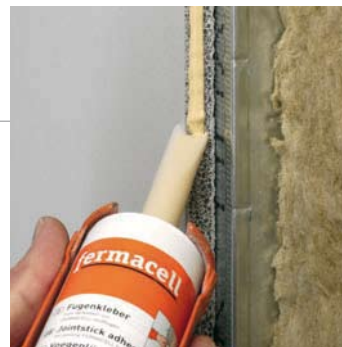
Appliquer la colle à joints FERMACELL sur le milieu du chant de la plaque
